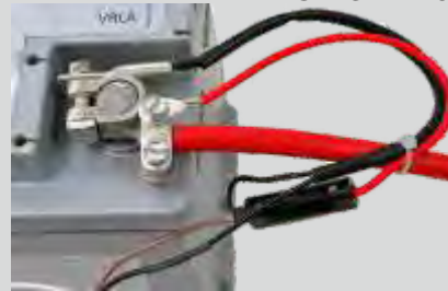
Anschluss des Temperatursensors an den + Polschuh der Batterie
