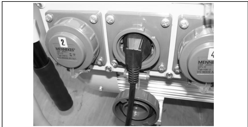
Abb. 4-3: Verbraucher anschließen
