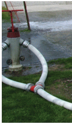
Abb. 4.2: Überflurhydrant und Standrohr am Unterflurhydranten
