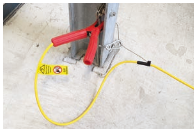
Erdung am Fundamenteirder
