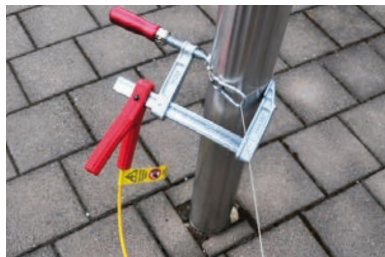
Erdung am Mast mit Hilfe einer Schraubzwinge
